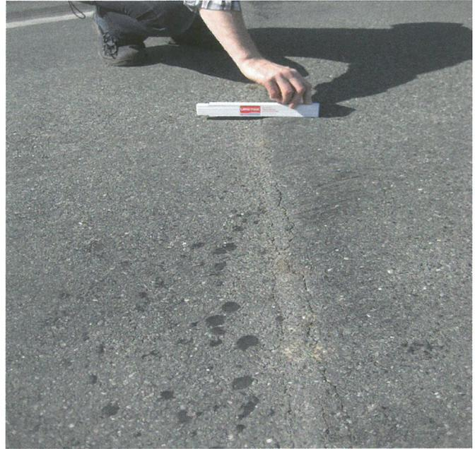
Bild 17. Südliche Rampe mit 1 cm Absatz zum Brückenbauwerk zehn Jahre nach der Erneuerung (Situation am 4. September 2014, Blickrichtung Westen)
