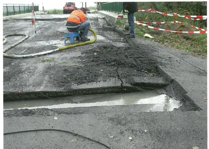
Bild 10 a und b. Gefräster Teil der Straßenrampe der Indiekkanalbrücke; im rechten Bild heben des Asphaltes mit Riss und mit Oberflächenwasser gefüllter quergefräste Fläche, um das Heben nur auf die Fräsfläche zu beziehen; Nordrampe, Blickrichtung Offenwarden.
