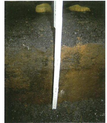
Bild 12 a und b. Bis zu 30 Zentimeter gehobener gefräster Asphalt im Bereich der Stahlschiene zwischen Brücke und Straßenrampe (Südrampe, Blickrichtung Westen)
