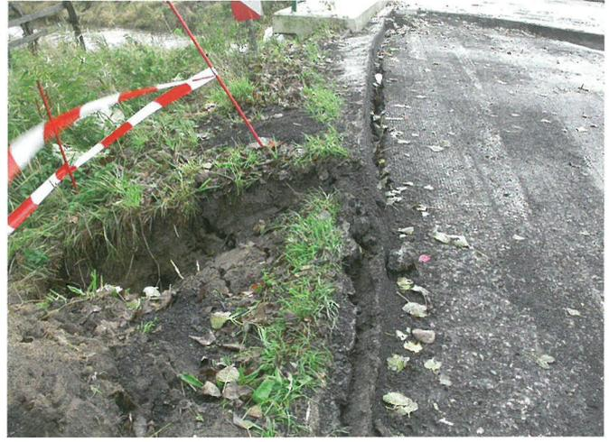
Bild 11 a und b. Hebung des Asphalts im Bereich der Fuge zur Brücke (links, Nordrampe) und im Randbereich (rechts, Südrampe, Blickrichtung Sandstedt)
