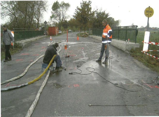
Bild 8. Der Asphalt wurde durchbohrt, ein Kupferröhrchen in das Bohrloch gesteckt, die Injektionspistole auf das Kupferröhrchen gesetzt und injiziert. Den Grad der Hebung konnte man anhand eines Messwertgebers über eine lasergesteuerte Nivelliereinrichtung ablesen; Südrampe, Blickrichtung Sandstedt.
