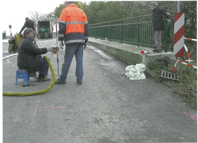
Bild 9. Das Expansionsharz tritt im Bereich der nicht mehr intakten Entwässerungseinrichtung aus. Im Hintergrund sieht man die Baustelleneinrichtung (Lkw) für die Injektion. Am linken, oberen Bildrand ist das Schneiden des Asphalts im Übergang zwischen Brücke und Straßenrampe zu sehen; Nordrampe, Blickrichtung Offenwarden.
