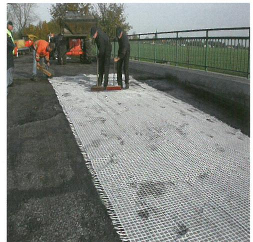
Bild 13 a und b. Verlegen der Asphalteinlage, Südrampe
